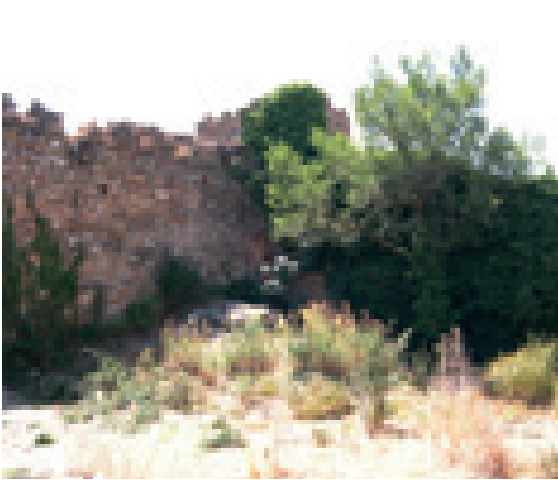
Recuperación de lienzos murados de la zona meridional
