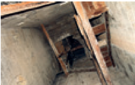
Interior de la torre campanario. Antes de la intervención
