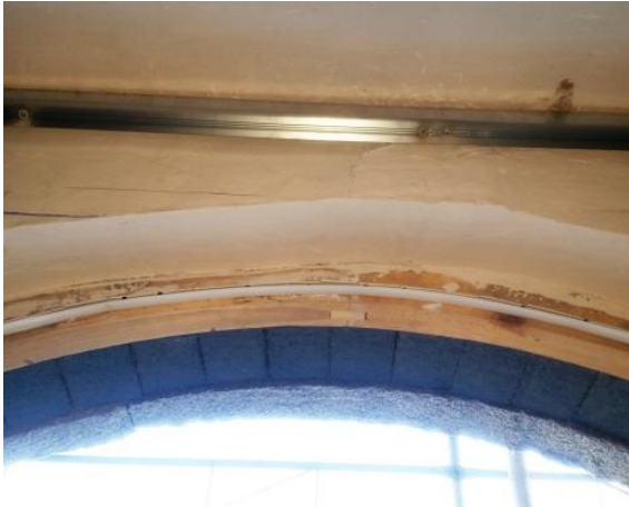
Figura 3. Sobre-aislamiento de los arcos de las ventanas originales
