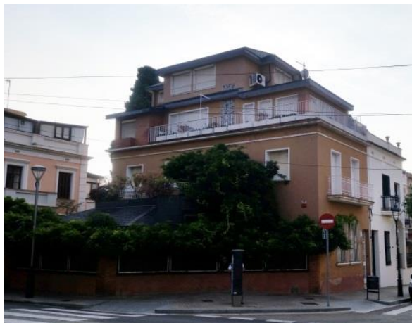
Figura 1. Vivienda antes de la rehabilitación
