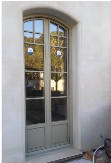
Figura 5. Balconera de Planta Baja
