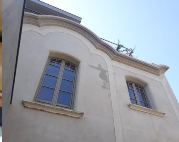
Figura 4. Molduras y curvas en jambas y dinteles de las ventanas
