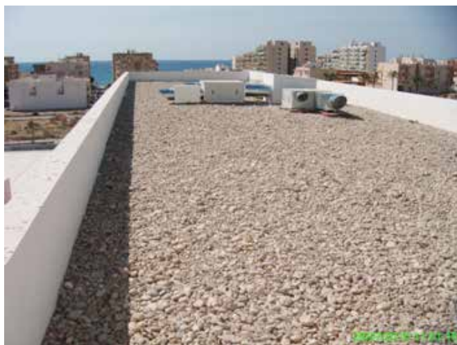
Imagen: Cubierta no transitable, con peto perimetral de altura suficiente para la protección durante la realización de trabajos posteriores de mantenimiento. Fuente: Fernando Espinosa Gutiérrez
