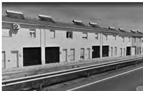
Figura 1. Paneles solares en cubierta sin acceso:
