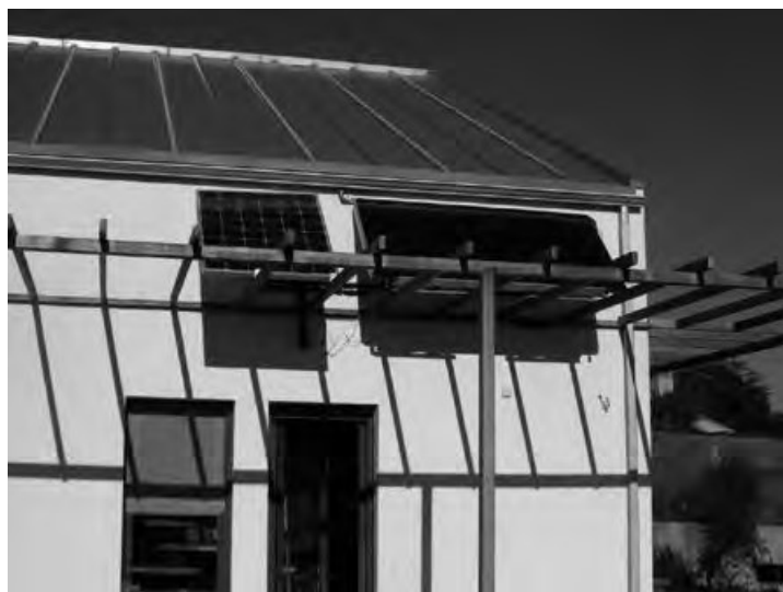
Figura 9. Panel solar térmico convencional (derecha) y uno fotovoltaico a la izquierda.
