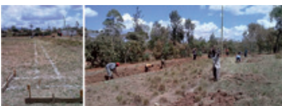
Figura 4. Trabajos de realización de la cimentación. Fuente: Pedro Bel Anzué, arquitecto y arquitecto técnico.
