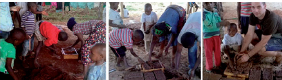
Figura 8. Participación de los niños y profesores en la realización de adobes. Fuente: Pedro Bel Anzué, arquitecto y arquitecto técnico.
