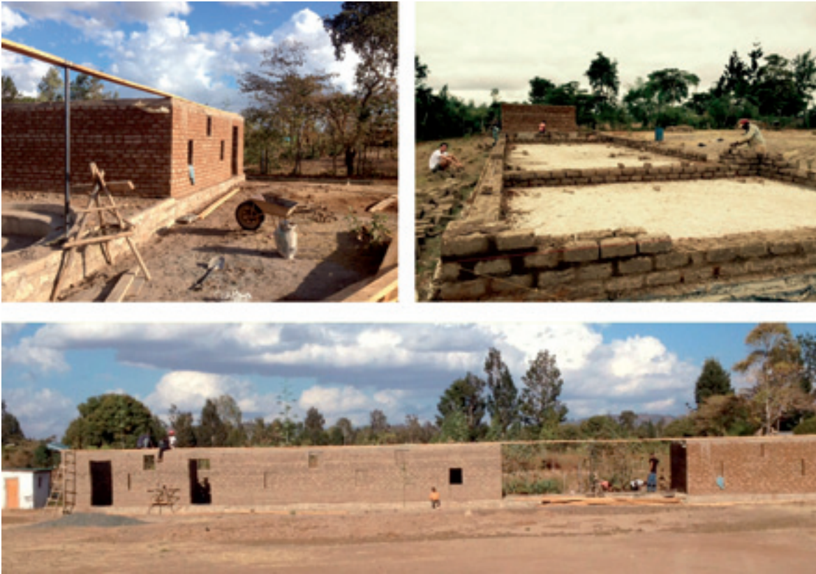
Figura 11. Finalización del edificio. Fuente: Pedro Bel Anzué, arquitecto y arquitecto técnico.
