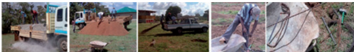
Figura 5. Materiales y trabajo. Fuente: Pedro Bel Anzué, arquitecto y arquitecto técnico.
