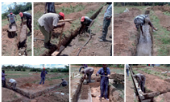
Figura 6. Cimentación y sobrecimiento. Fuente: Pedro Bel Anzué, arquitecto y arquitecto técnico.
