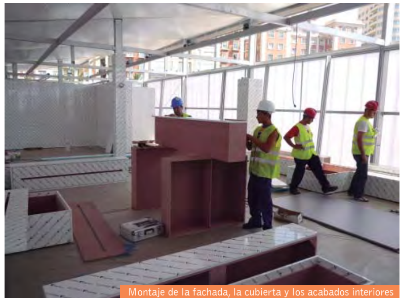
Montaje de la fachada, la cubierta y los acabados interiores
