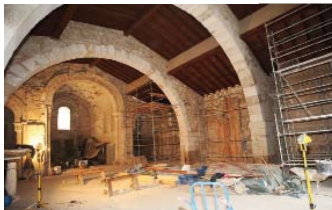
Arriba, el muro sur una vez finalizada la cubierta y retirados los apeos. Abajo, vista genérica del interior.
