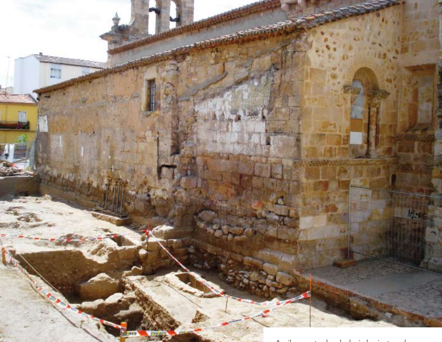
Arriba, estado de la iglesia tras la excavación arqueológica. Abajo, desmontada la hoja exterior del muro, se observa detrás del apeo la situación de la portada sur en las dos hojas del muro. A la derecha, detalle del cosido de la hoja exterior a la interior.
