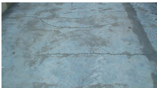
Fig. 1: ejecución solera de hormigón.
