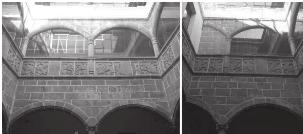
Figura 2. Fachadas del patio: sureste (izq.) y suroeste (dcha.). Imágenes del autor.
