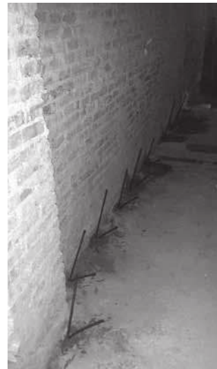
Figura 6. Perforaciones, previo a la inyección de resina, junto al muro de carga de la escalera. Fuente: imagen de los autores.
