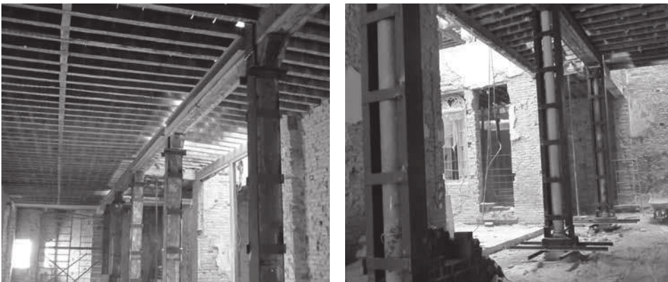
Figuras 12 y 13. Vista general de las plantas baja y tipo durante los trabajos de refuerzo estructural. Fuente: imagen de los autores.
