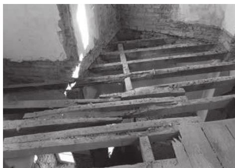
Figura 7 (izq.) y Figura 8 (dcha.). Zonas de forjado con viguetas y tablero deteriorados y sustituidos posteriormente. Fuente: imagen de los autores.
