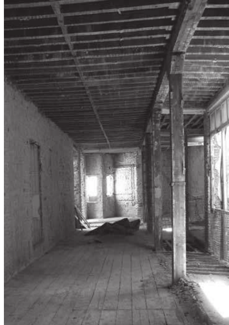
Figura 2. Vista parcial de la edificación con los elementos estructurales vistos. Fuente: imagen de los autores.
