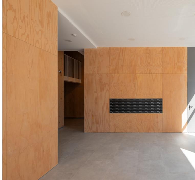
› L'estructura de l'edifici està feta íntegrament amb 1.103 peces de fusta.
