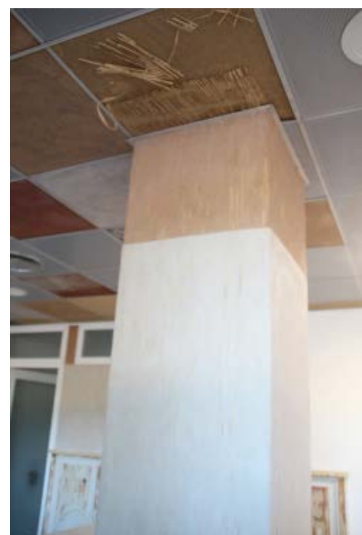
Recuperació dels falsos sostres de la zona d'oficines de l'antiga lampisteria, que eren de plaques metàl·liques perforades
