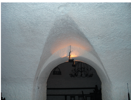
Bóveda de lunetos en sótano
