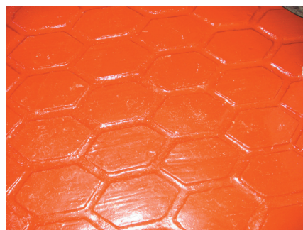
Detalle de pavimento en sótano
