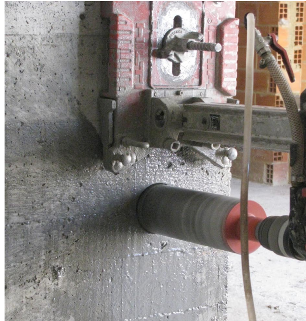
Figura 8. Extracción de un testigo
