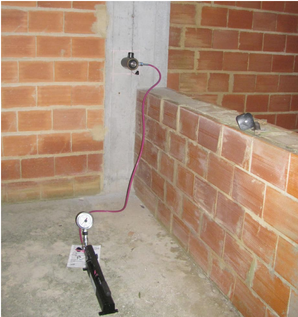
Figura 7. Ensayo pull-out en un pilar
