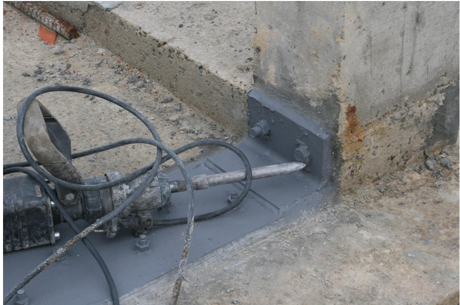
Figura 10. Aumento de la resistencia de una viga recurriendo a chapas metálicas.
