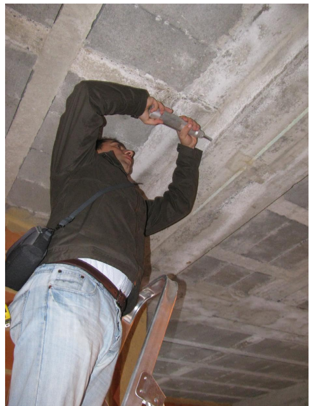
Figura 6. Ensayo con esclerómetro de Schmidt en una viga
