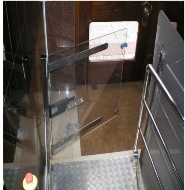
Puerta de salida automática
