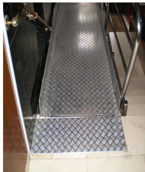
Acceso superior a la Rampa
