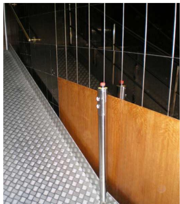
Poste inferior de mando
