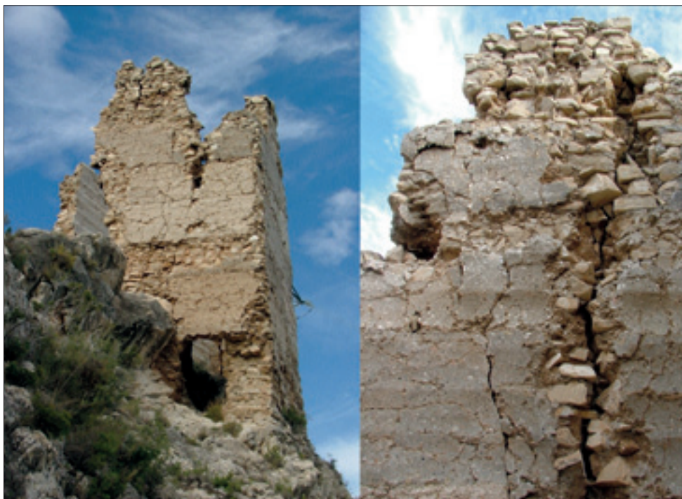
Foto 6. Aspecto de las torres medievales de Alcaine fabricadas con mampostería y hormigón de yeso.
