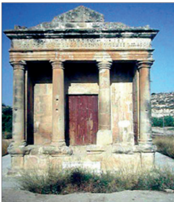
Foto 4. Aspecto general del mausoleo romano de Fabara. Construido en el s. II (época trajana) de nuestra era con impermeabilización de cimientos y cosido de sillares con grapas antisísmicas
