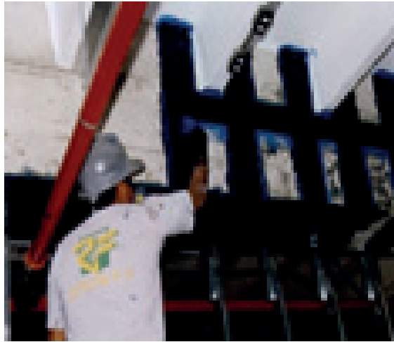
Reforzamiento por corte y flexión de viga estructural en Edificio Chocavento – San Isidro
