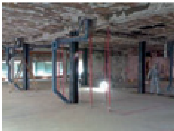
Restitución de la sección original del pilar con mortero epoxi SIKADUR 41. El empleo de morteros hidráulicos de reparación estructural es viable pero obliga a esperar de 10 a 15 días hasta disipar la humedad para aplicar los adhesivos epoxi
