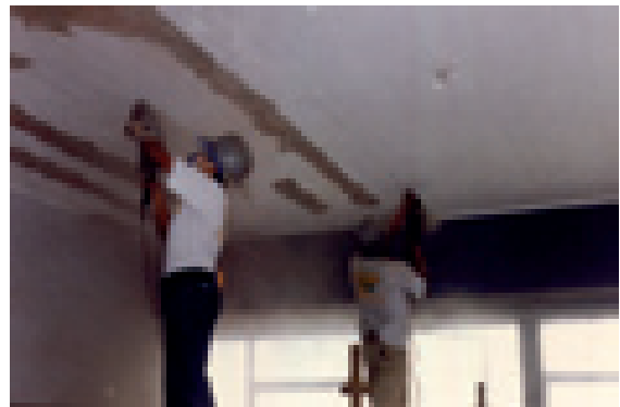
Preparación previa de la superficie en una losa aligerada. Reforzamiento de losa de sótano en local de Telefónica de Perú en Surquillo
