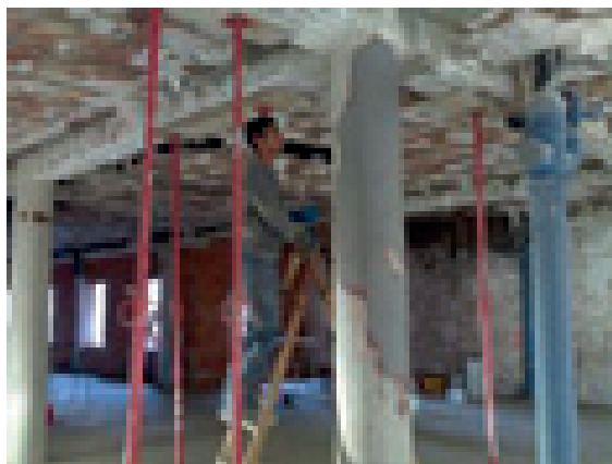
Restitución de la sección original del pilar con mortero epoxi SIKADUR 41. El empleo de morteros hidráulicos de reparación estructural es viable pero obliga a esperar de 10 a 15 días hasta disipar la humedad para aplicar los adhesivos epoxi
