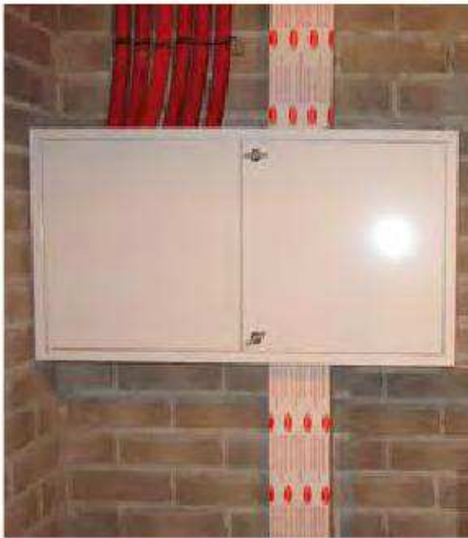
Ejemplo instalación de un Reg. Sec. Planta
