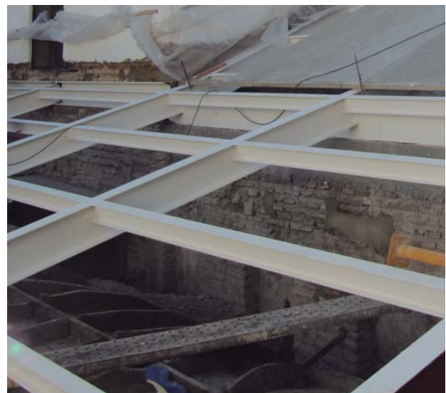
Estructura metálica con tratamiento ignífugo
