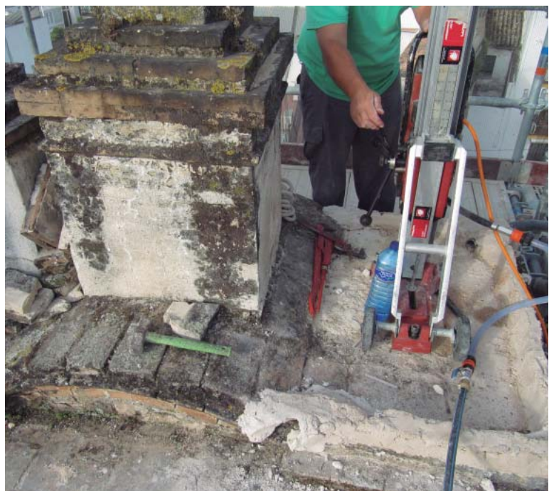
Medio utilizado para realizar las perforaciones, donde es fundamental la nivelación y aportación de agua
