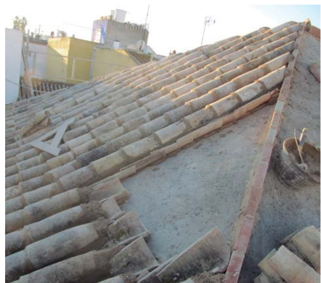
Detalle de ejecución de limatesas y colocación de tejas
