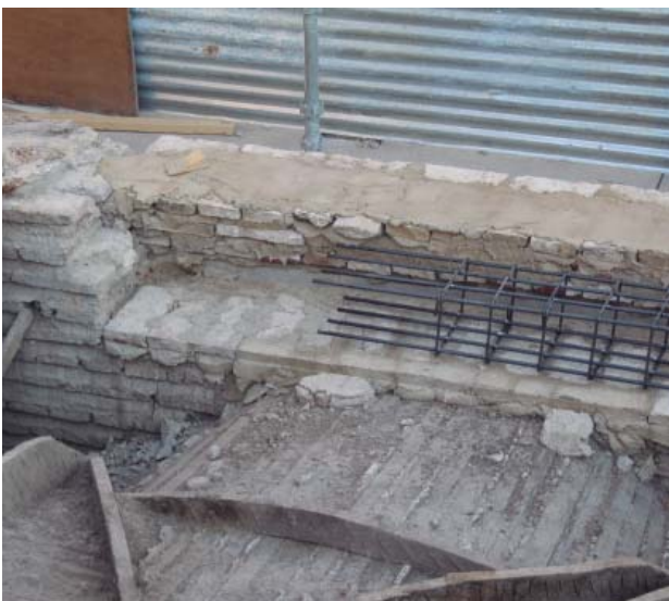
Desmontaje de faldón y rebaje de muro para ejecución de riostras
