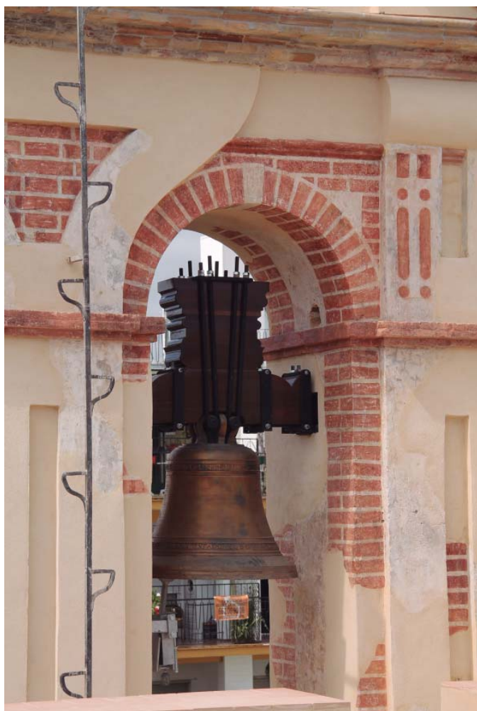
Estado final de los trabajos de restauración y colocación de nuevos yugos en las campanas
