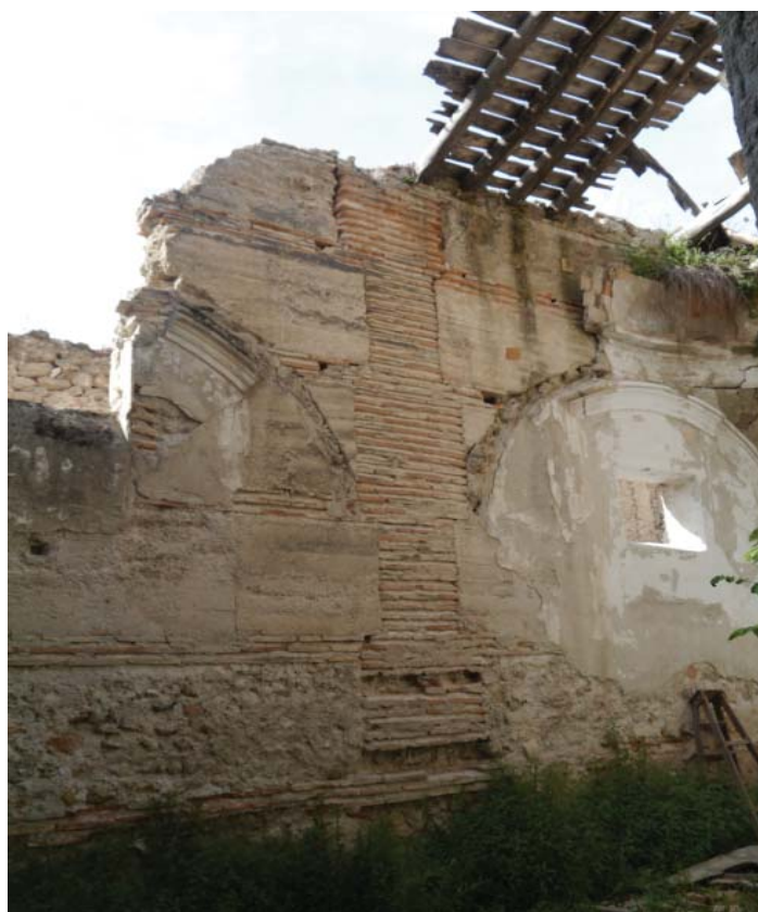
Foto 4. Muros y faldón de cubierta lateral
