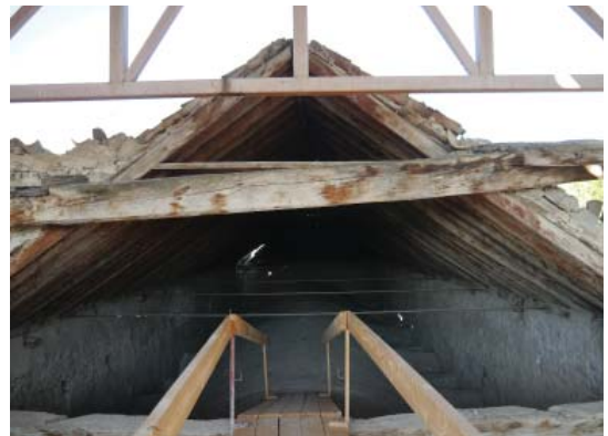
Foto 5. Bóvedas de la nave central
