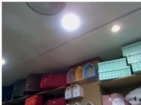
7-Inspección falso techo local comercial
