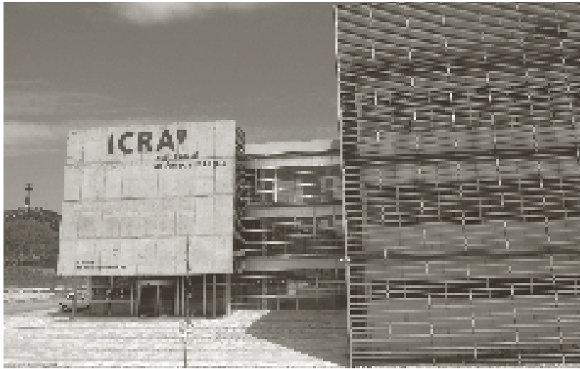
Edifici Institut Català de Recerca de l'Aigua (ICRA). (Foto: MMV).
