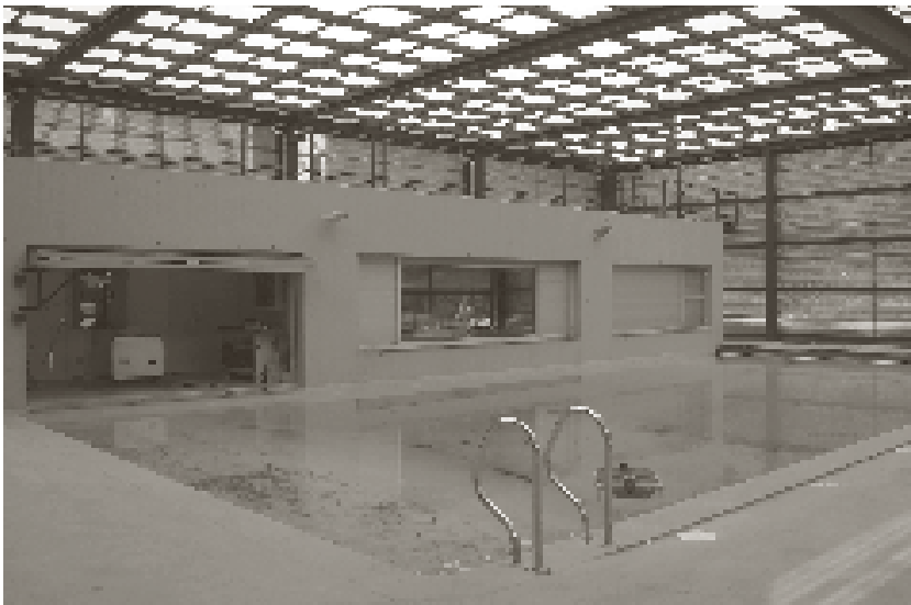
Edifici Centre d'Investigació en Robòtica Submarina de la UdG. (Foto: Mia Masgrau).
