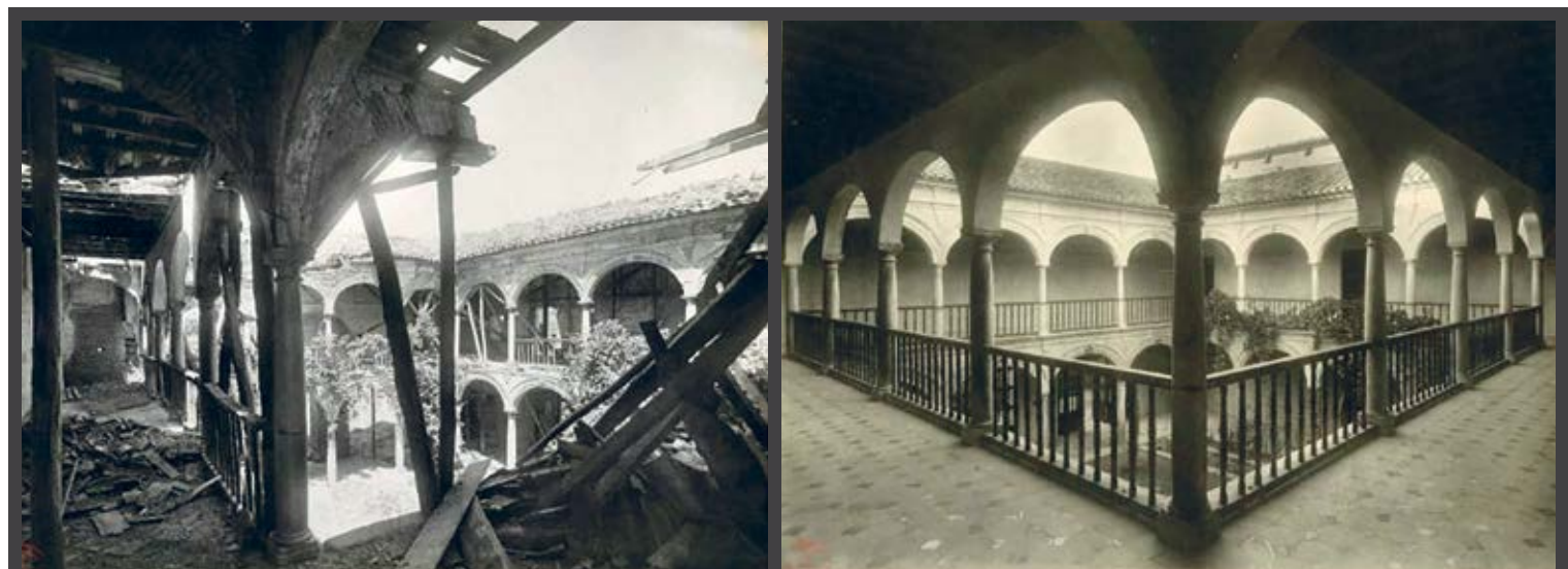
Lámina 2. Estado del claustro de San Francisco de la Alhambra antes y después de la restauración de Torres Balbás, fot.: Archivo Patronato Alhambra y Generalife (APAG).
