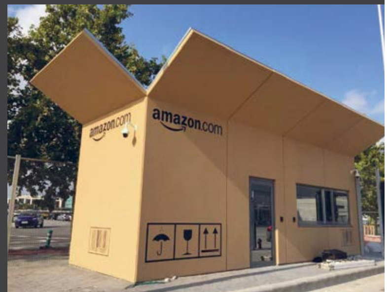
Centro logístico de Amazon, Barcelona (Fotografía cortesía de Prefabricast Planas).
