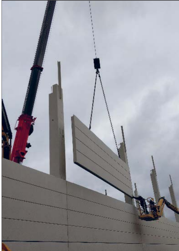
Fachada industrial con panel horizontal con falsas juntas (Fotografía cortesía de Preteresa Prenavisa).
