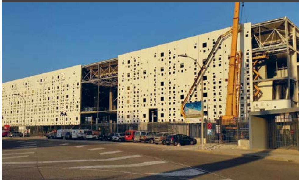
Panel prefabricado de hormigón blanco con acabado liso y perforados con huecos formando celosía, Nuevo Centro de Exposiciones, Ferias y Convenciones de Córdoba (Fotografía cortesía Prefabricados Hermanos Quijada).
