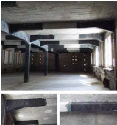
Figura 9. Refuerzo de estructuras con fibra de carbono. Alidzkaria 228, pp. 8-10
