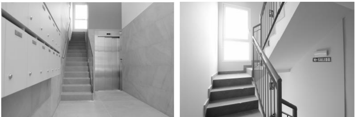
Figura 6. Fotografías obra terminada Calle Monte Ibañeta 4 de Pamplona. Fuente propia.
