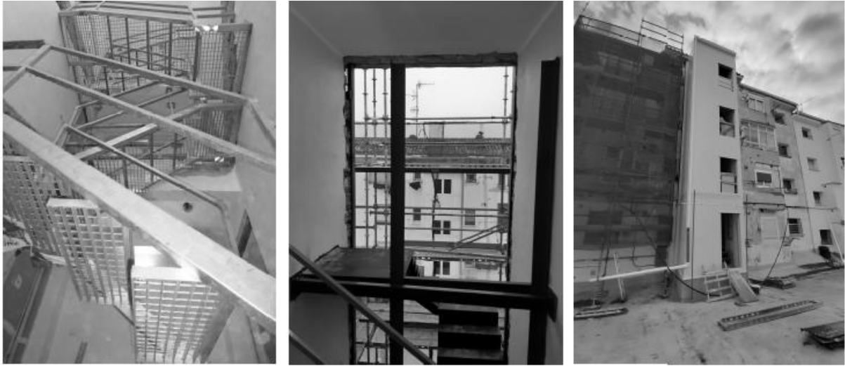
Figura 5. Fotografías fase de obra edificio Calle Monte Ibañeta 4 de Pamplona. Fuente propia.
