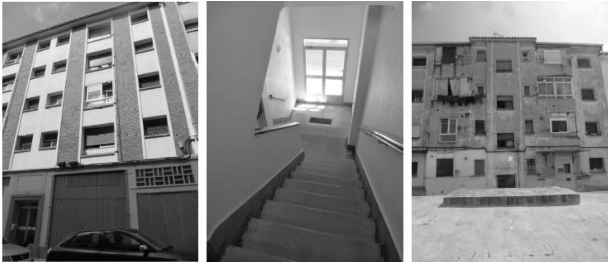
Figura 4. Fotografías estado inicial edificio Calle Monte Ibañeta 4 de Pamplona. Fuente propia.
