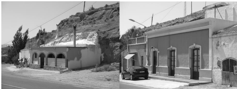
Figura 3. Ejemplos de cueva excavadas complementada o adaptadas en zona de Gádor (Almería).
