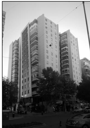
Figura 26. Fachada terminada con Composite
