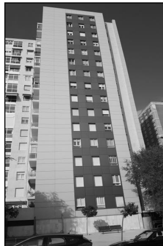
Figura 28. Fachada terminada con Composite
