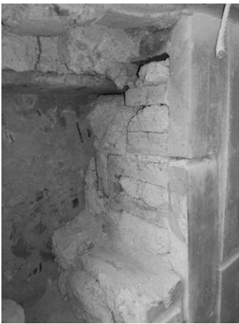
Figura 9. Detalle apoyo ladrillo.
