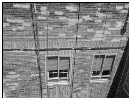
Figura 14. Relleno de ladrillos caravista y dinteles metálicos colocados.
