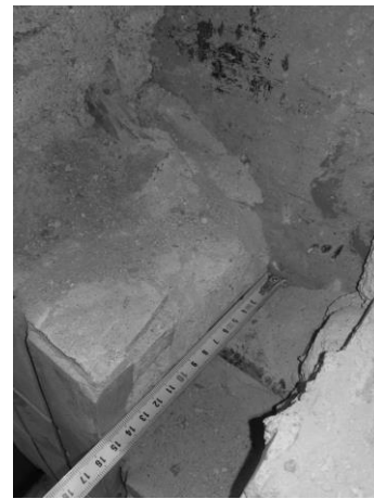
Figura 10. Detalle apoyo ladrillo (1/3)
