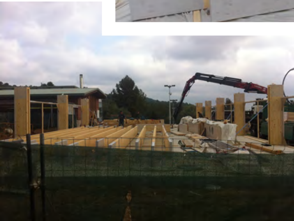
Muntatge de l'estructura de fusta
