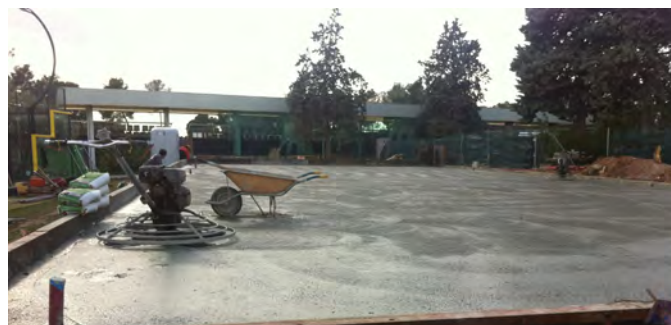
Procés d'execució de la llosa
