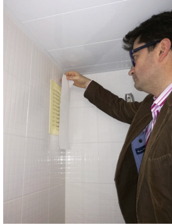
Fig. 3 Manca de funcionament d'un conducte de ventilació per tir tèrmic
