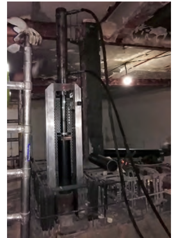
FIGURA 7 Proceso de hincado del micropilote por presión continua.
