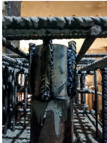
FIGURA 6 Camisa metálica embebida en encepado provisional.
