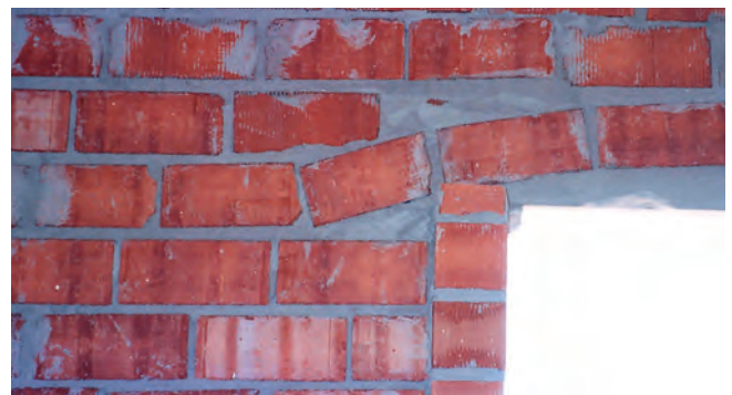
Figura 5: solución de dintel con arco de descarga.
