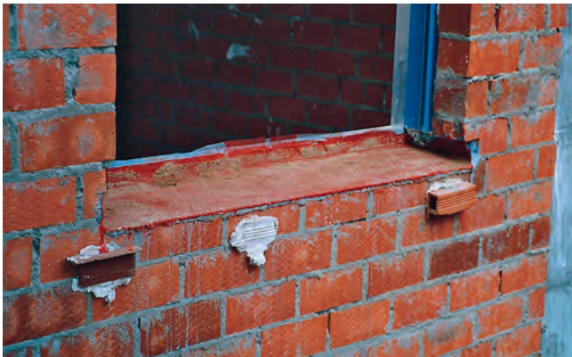
Figura 4: impermeabilización inferior de un vierteaguas.
