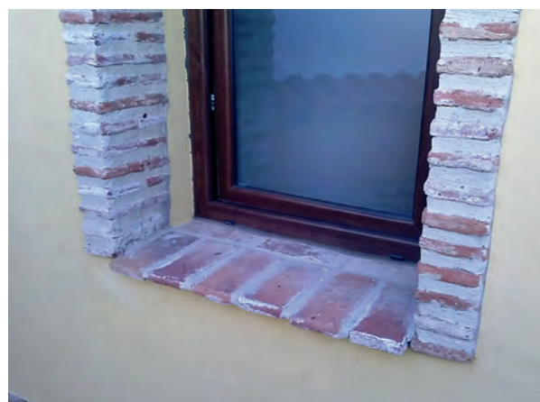
Figura 1: vierteaguas discontinuo realizado con ladrillo manual.
