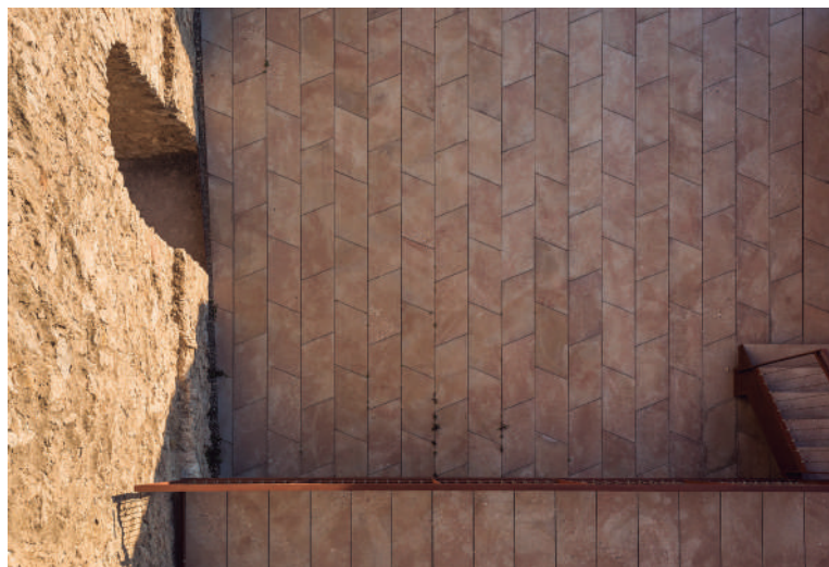
Detall de la nova pavimentació
