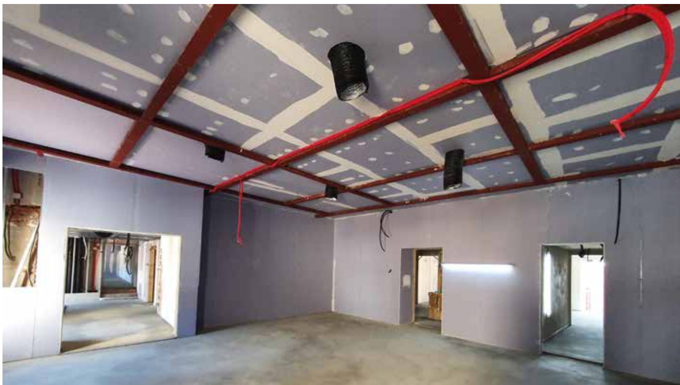
El nou plató en formació. Es pot apreciar la pell acústica.
