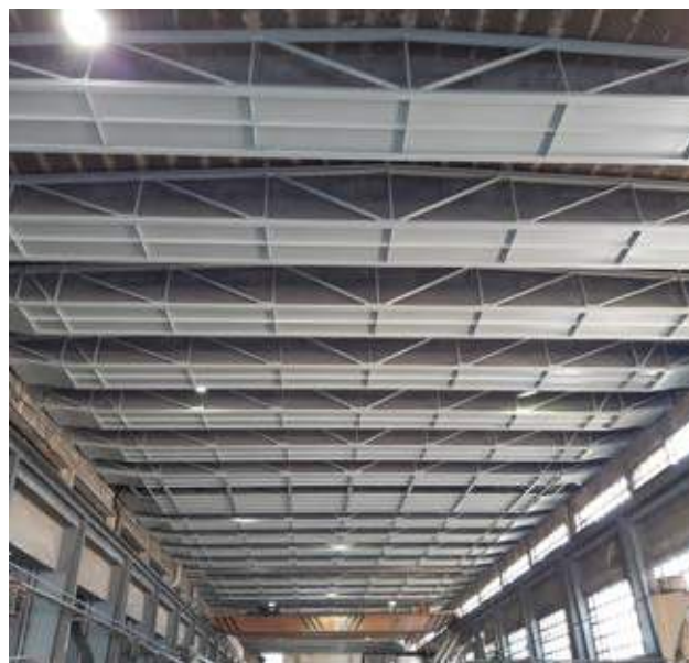
Vista d'una de les dues naus amb els treballs acabats.
