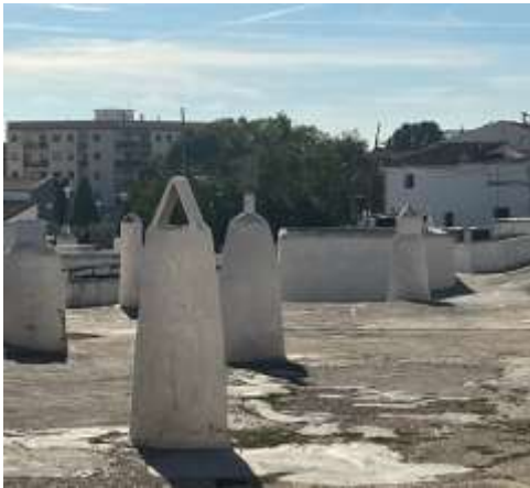
Figura 2. chimeneas de ventilación. Fuente: Elaboración propia.
