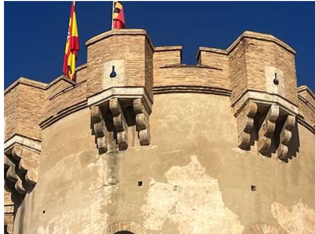
Figura 7. Vistas de la torre. Detalle de los matacanes restauración 1971. Fuente: Elaboración propia.
