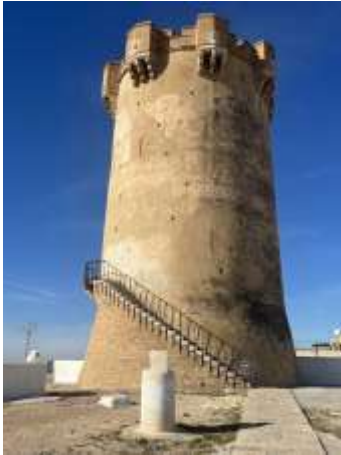
Figura 6. Vista exterior de la torre Escalera exterior realizada en el año 1971. Fuente: Elaboración propia.
