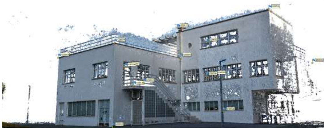
Figura 6. Nube de puntos detallada de la fachada trasera de la fábrica Laborde Hermanos (Andoain) junto con los puntos de control obtenidos mediante GNSS.
