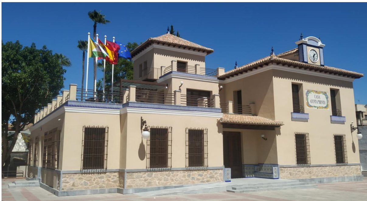
Figura 1. Villa Carmencita o Casa-Ayuntamiento después de la Rehabilitación realizada.
