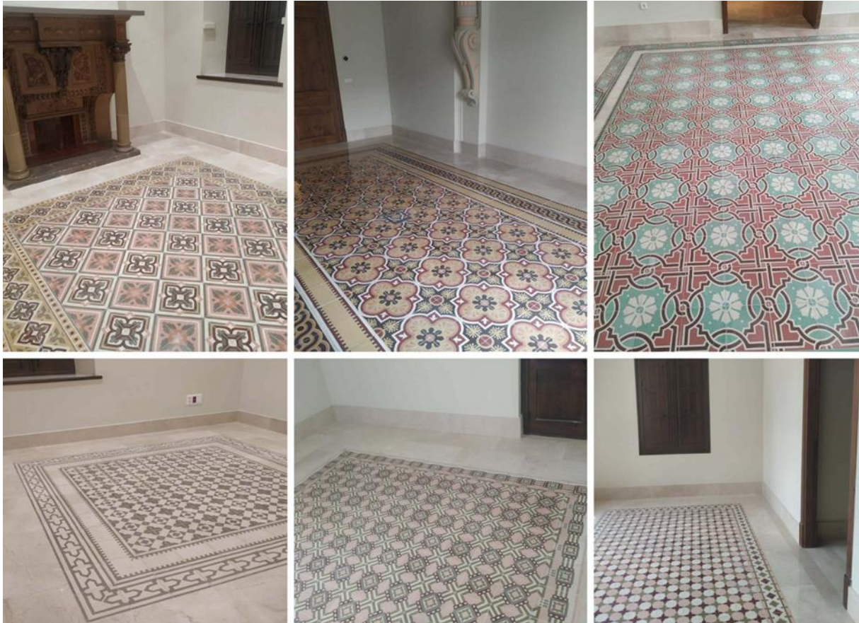
Figura 4. Detalle de diferentes solados de baldosa hidráulica del interior del edificio.
