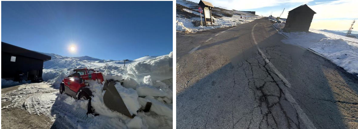
Figura 2. Condiciones de accesibilidad en el entorno Pradollano–Borreguiles (Sierra Nevada). A la izquierda, maquinaria atrapada tras un episodio de nevada intensa, evidenciando la interrupción de la operatividad y la dependencia de medios auxiliares; a la derecha, estado del firme con fisuración y acumulaciones de nieve. Estas situaciones ilustran la vulnerabilidad del acceso y su influencia directa en la planificación logística y la continuidad de las intervenciones. Fuente: los autores (izquierda) y Google Maps (derecha).
