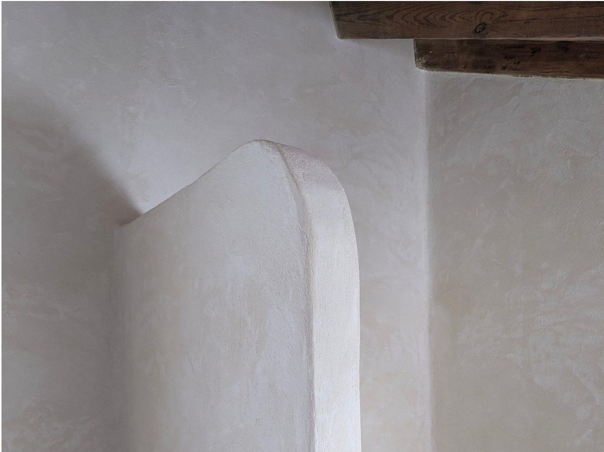
Figura 2. Capa de regularización aplicada
