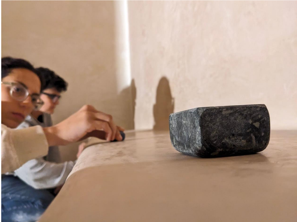
Figura 3. Bruñido con piedras de ágata y basalto porfídico
