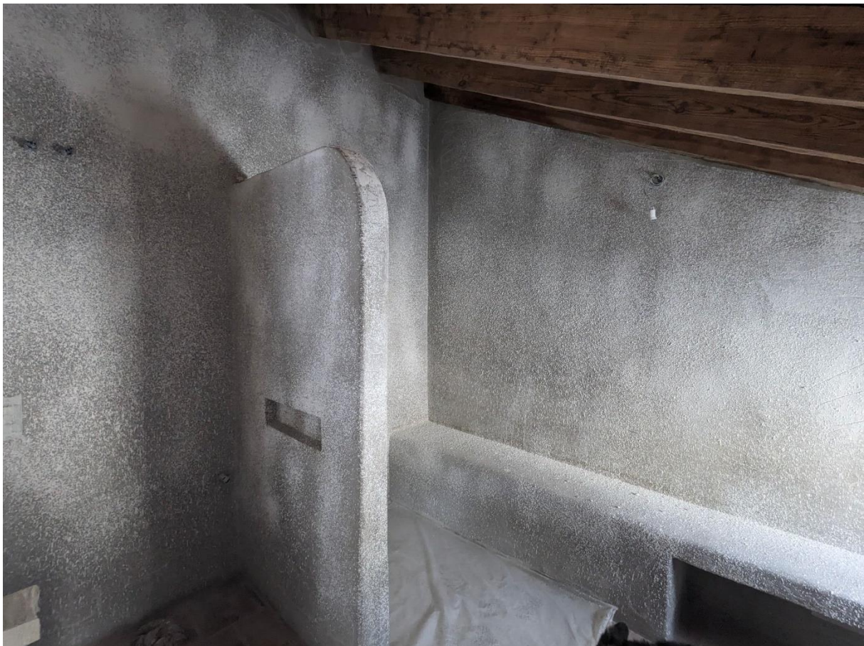
Figura 1. Puente de unión mineral aplicado mediante salpicado con tirolesa
