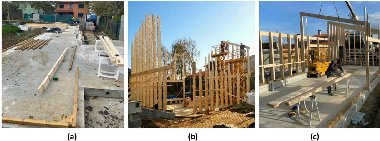
Figura 6. Fotos de ejecución: (a) Estado inicial de acopio. (b) Ejecución de pórtico. (c) avance de ejecución.
