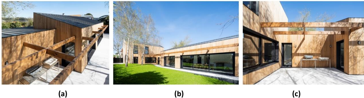
Figura 7. Resultados: (a) Vista aérea de la cubierta. (b) Vista general de cuerpos a dos y un agua. (c) Detalle de volumen intermedio. Fuente: Elaboración Propia
