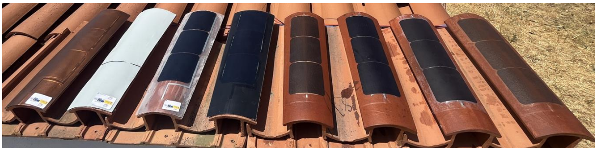
Figura 4. Instalación en cubierta de edificio de los elementos BIPV desarrollados con diferentes acabados
