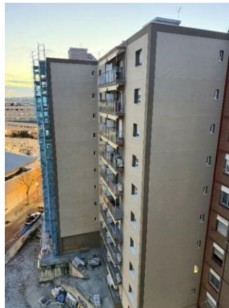
Figura 1. Vista general rehabilitada del bloque 4
