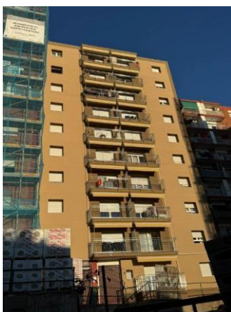
Figura 11. Acabado final del sistema SATE con lana de roca (material incombustible).
