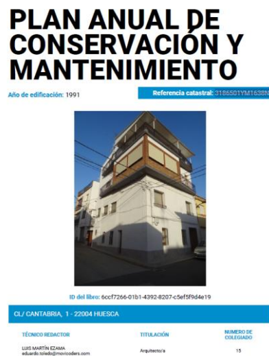
Figura 1. Informe que recoge el plan de conservación y mantenimiento.
