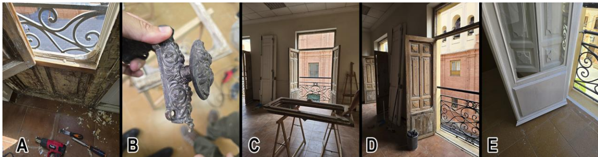
Figura 5. Vistas de la restauración de carpinterías. (A) Inicio de los trabajos (B) Ejemplo de herraje original en reparación (C) Proceso de reparación con taller in situ (D) Vista de un ventanal en avanzado proceso de restauración (E) Acabado final de las carpinterías restauradas. Fuente: Los autores
