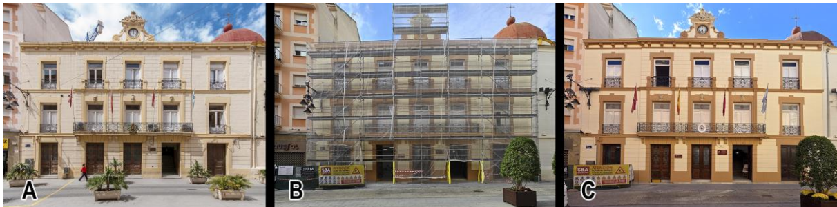
Figura 4. Vistas generales de la intervención en fachada y su evolución (A) Fachada antes de comenzar la intervención (B) Fachada durante la intervención (C) Fachada acabada la intervención con las nuevas tonalidades cromáticas. Fuente: Los autores
