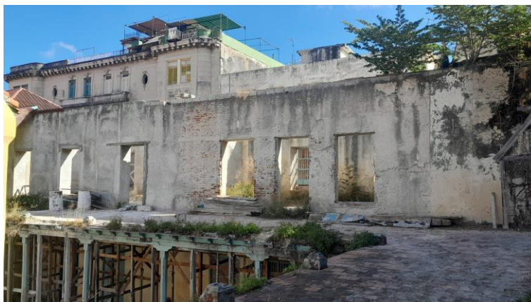
Figura 1. Claustro 4, Convento de Santa Clara. La Habana (Cuba)
