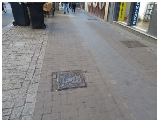
Figura 3. Pavimento calle S. Vicente.
