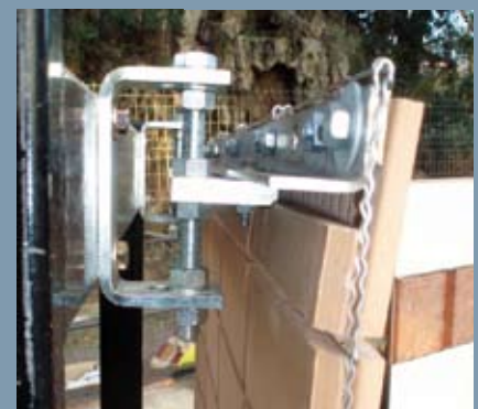
Arriba, anclaje de retención. Abajo, escuadras y guía de sustentación.
