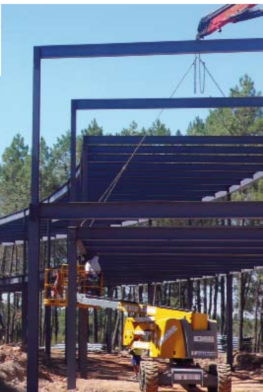
Fase de ejecución de estructuras. Montaje del segundo forjado, realizado a base de chapas colaborantes y losas de hormigón.
