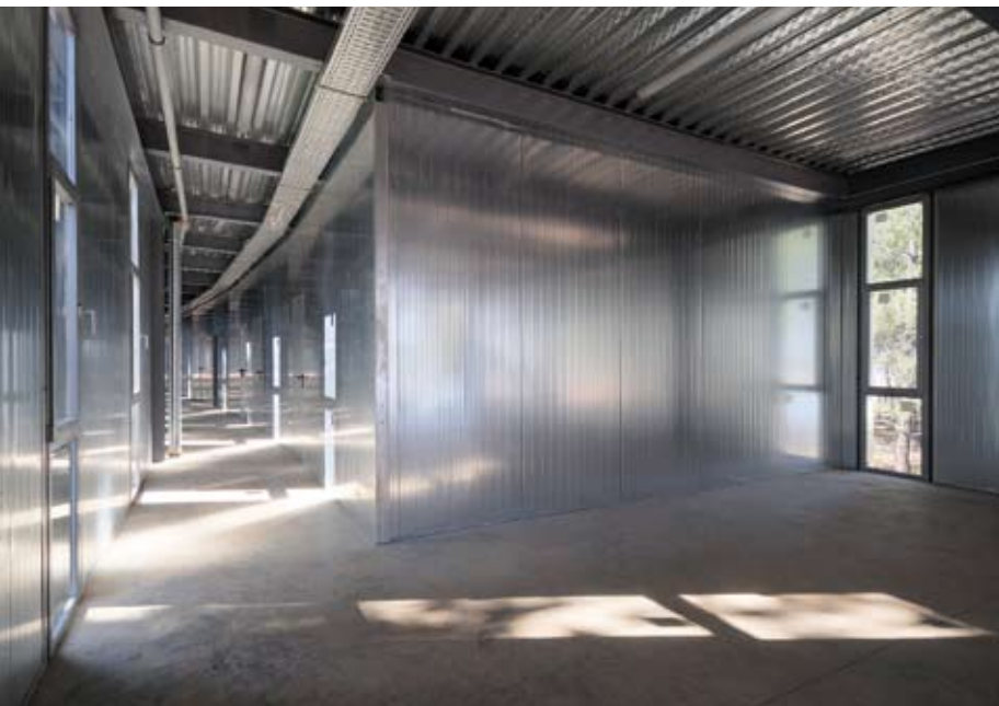
Arriba, detalle del revestimiento exterior del edificio. Abajo, detalle del interior en el que se aprecian los tabiques realizados con los paneles sándwich de chapa galvanizada.
