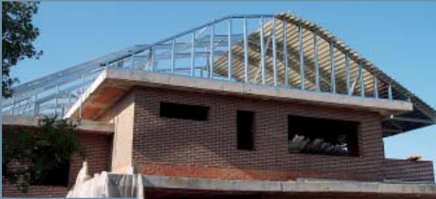
Vista general del montaje de una cubierta LARK.
