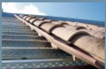
Colocación de tejas
